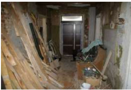
Dzīvojamā ēka ar kadastra apzīmējumu 1700 020 0388 001, koplietošanas telpa
