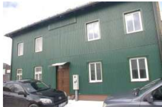
Dzīvojamā ēka ar kadastra apzīmējumu 1700 020 0388 001, kopskats no Lietuviešu ielas puses
